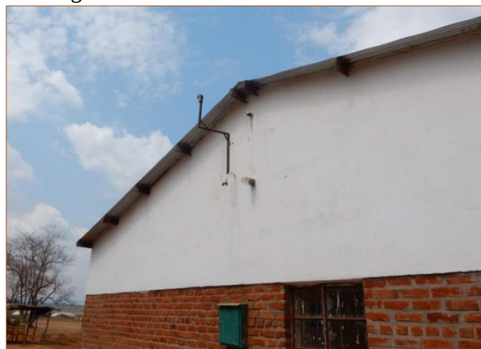
• Het punt waar de kliniek nog aangesloten moet worden op het elektriciteitsnet
